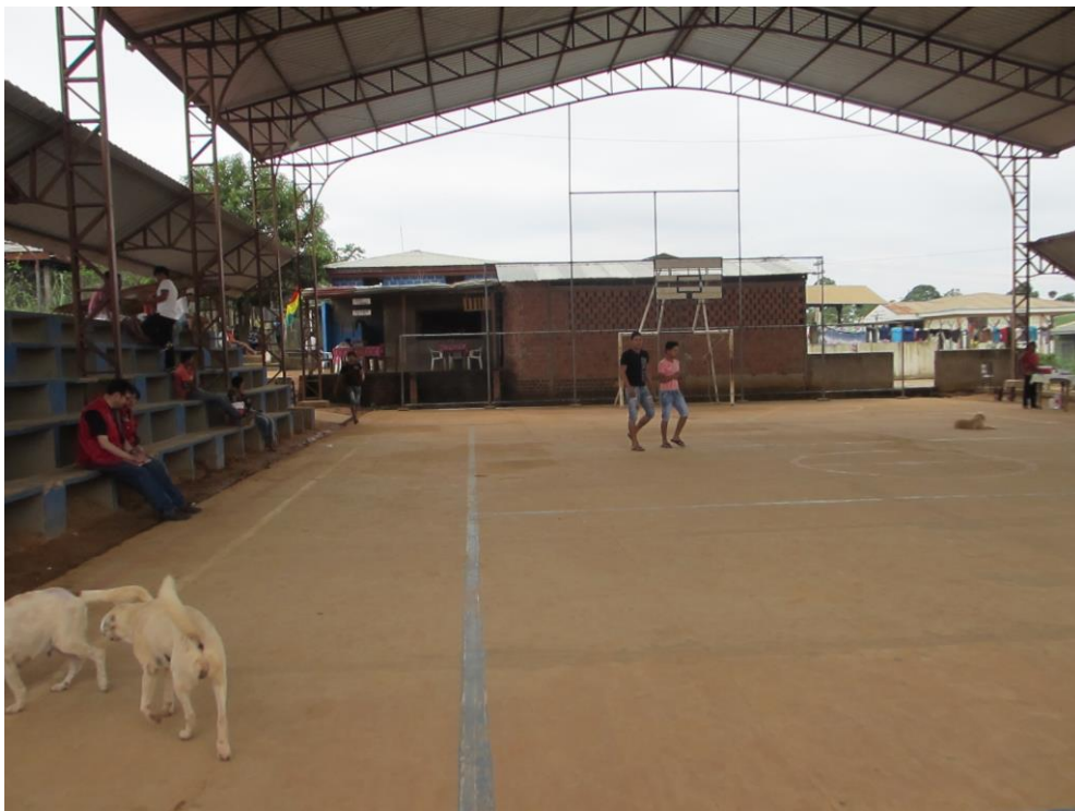
Patio de la cárcel donde se reúnen los privados de libertad
