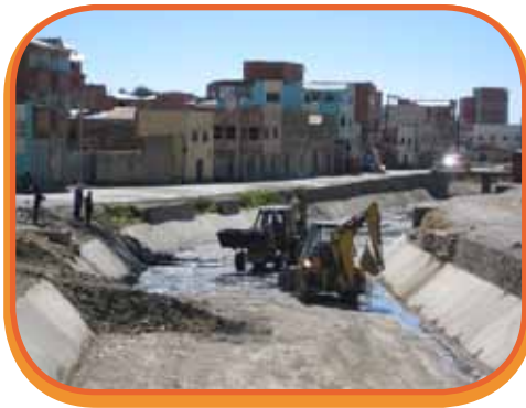
Día de limpieza del cauce mediante excavadora (24.09.2009)
